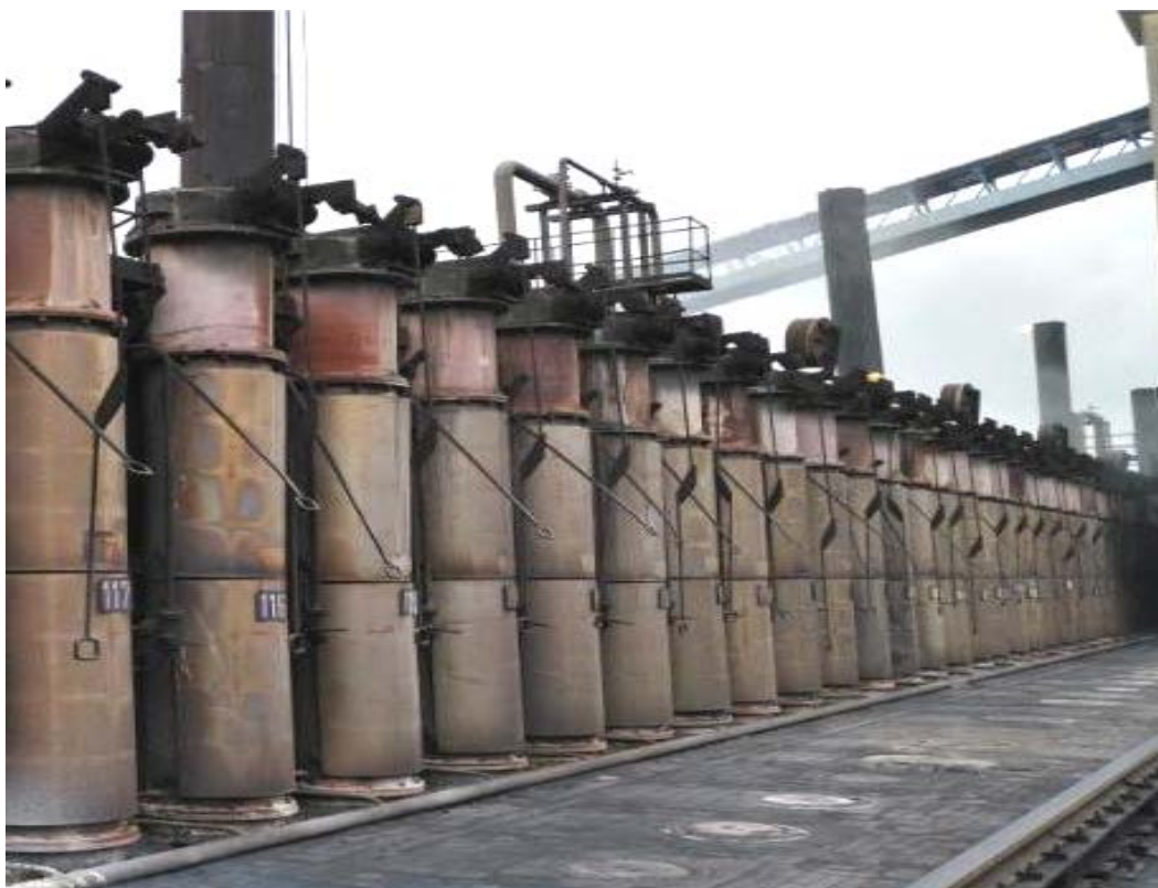
图 2 柳钢二焦车间荒煤气余热利用工程现场
